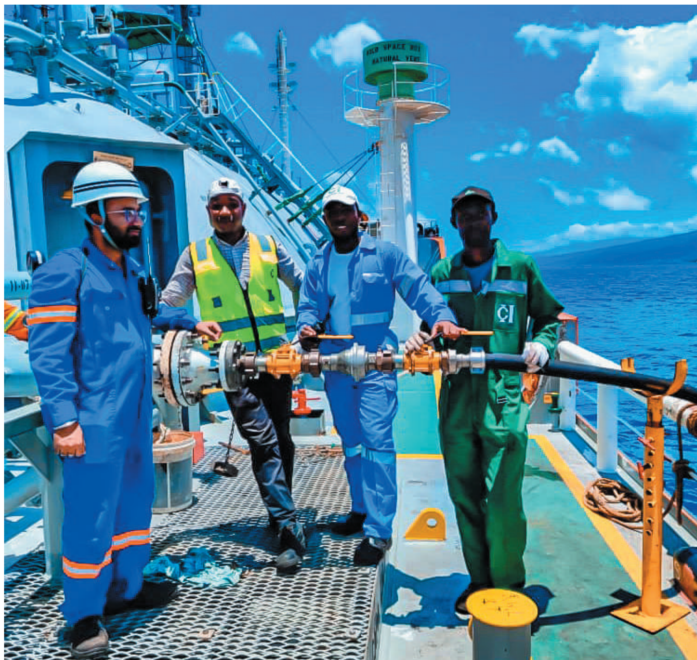
Déchargement du gaz importé
